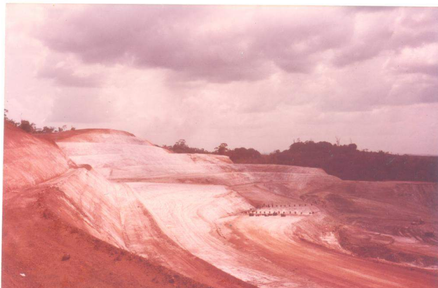
Figura 24 - Imagem panorâmica do Garimpo de Serra Pelada – Pará. Método de exploração de barranco à céu aberto – 1985. Fonte: Arquivo do artesão.
